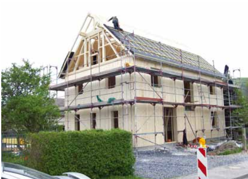
Realizzazione a Thuringen
